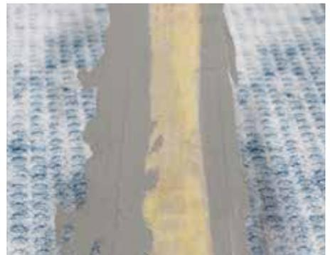
6. Sellar la banda con otra pasada de adhesivo impermeable y elástico en base cementosa (doble sellado).
