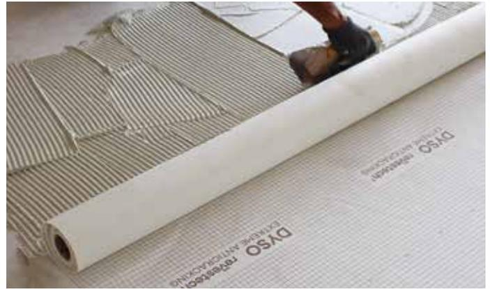
2. Aplicar cemento cola clase C2 S1/S2 con llana dentada de entre 4 y 6 mm. Aplicar el adhesivo en pequeños paños para evitar que se seque. En ningún caso instalar la lámina **DYSO** sobre un cemento cola semi fraguado.
