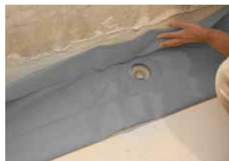
3. Extender la lámina **ECODRY50** sobre el propio adhesivo, remontando por la pared un mínimo de 10 cm.
