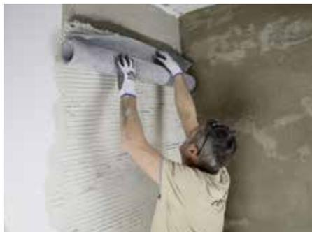
5. Extender una capa fina de cemento cola C2 S1/S2 con la llana de 4 mm y revestir la pared con la lámina **ECODRY50** dejando un solape entre láminas de al menos 5 cm.
