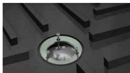
12. Colocar el aro metálico, insertar los tornillos y atornillar hasta sellar totalmente el aro a la salida del plato.
