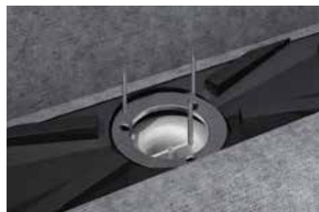
8. Colocar el aro metálico, insertar los tornillos y atornillar hasta sellar totalmente el aro a la salida del plato. Comprobar que la base del **LINEAL/SUMI LEVEL** esté totalmente a nivel. Recoger la lámina antes de formar las pendientes.
