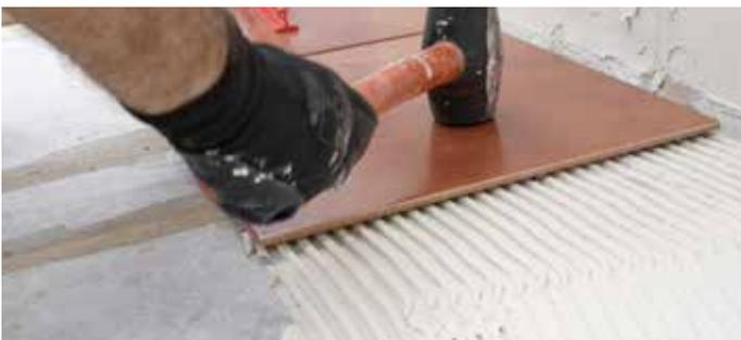
7. Colocar el pavimento directamente con cemento cola clase C2 S1/S2 y fijar el rodapié.
