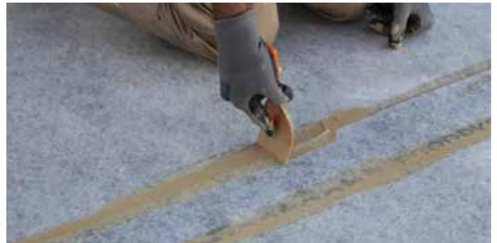
6. Realizar un doble sellado sobre los bordes de la banda con adhesivo **SEALPLUS**. OPCIONAL: Una vez finalizada la instalación, con un tiempo de espera de 48 horas, se puede realizar una prueba de estanqueidad precisa.
