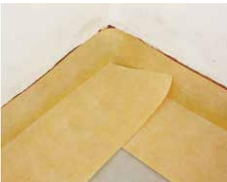
7. Realizar las uniones con los paramentos verticales solapando con **DRY BANDA** o **ECODRY BANDA** un mínimo de 10 cm y sellando con **SEALPLUS** sobre la lámina **ACU200**.
