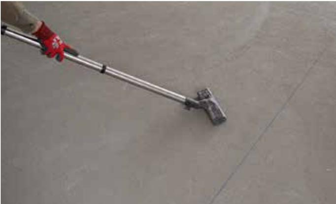
1. Comprobar la estabilidad del soporte y limpiar la superficie. El soporte no debe contener elementos que pudieran dificultar la adherencia de la lámina.
