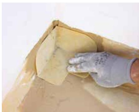
8. Utilizar los diferentes complementos **DRY** o **ECODRY** para resolver los puntos singulares.
