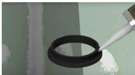
8. Crear un cordón de adhesivo **REVESTTECHFLEX** en todo el interior de la junta tipo labial.
