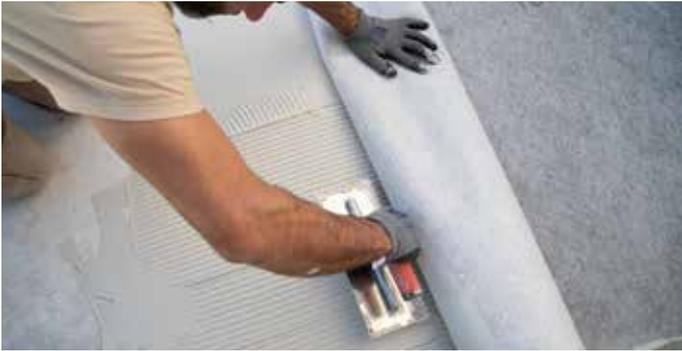
1. Comprobar la estabilidad del soporte y limpiar la superficie. A continuación aplicar cemento cola clase C2 S1/S2 con llana dentada de 6/8 mm. Aplicar el adhesivo en pequeños paños para evitar que se seque y siempre peinando en un único sentido. En ningún caso instalar la lámina sobre un cemento cola semi fraguado. Nota: en rehabilitación, aplicamos el cemento cola clase C2 S1/S2, directamente sobre el pavimento antiguo.
