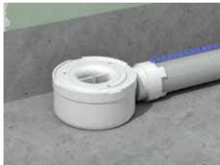
3. Conectar el sumidero, la tubería deberá tener una pendiente  $\geq 2\%$ . Comprobar la correcta evacuación. Rellenar con base de mortero, teniendo en cuenta los niveles de altura tomados y dejando suficiente holgura para ajustar el sumidero.
