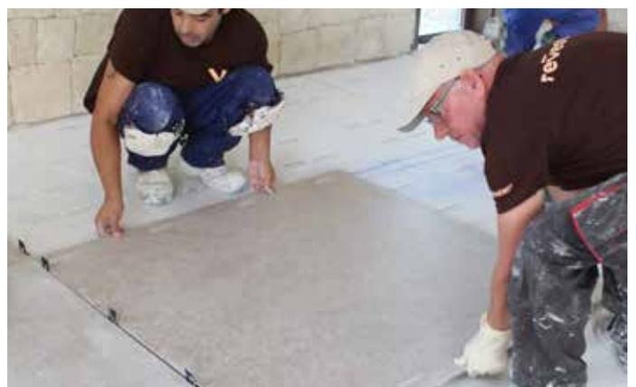
6. Antes de instalar la cerámica, esperar al menos 24 h. de secado del cemento cola de aplicación de la lámina. Utilizar el adhesivo recomendado por el fabricante de la cerámica para su adhesión a la lámina.
