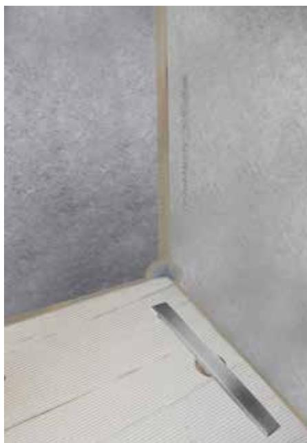
8. Tras el secado del adhesivo, volver a aplicar cemento cola C2 S1/S2 directamente sobre la lámina. Proceder a la instalación de la rejilla de acabado del kit y de la cerámica elegida como recubrimiento final.
