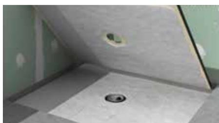
11. Instalar la base Level inmediatamente después sobre el adhesivo fresco.
