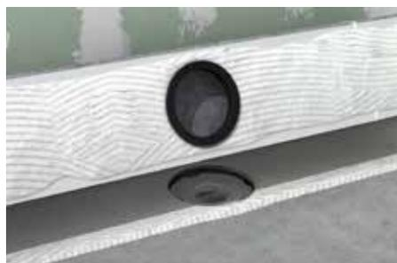
7. Una vez fraguado el mortero, aplicar cemento cola clase C2 S1/S2 realizando un doble encolado sobre el soporte y el reverso de la base del **LINEAL/SUMI LEVEL**.
