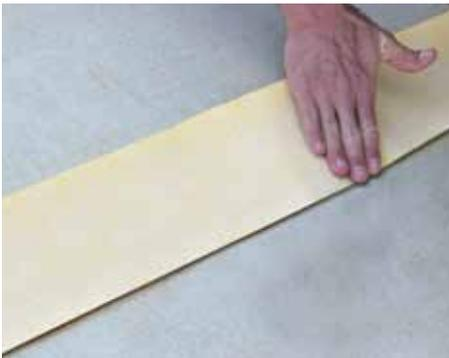
5. Realizar las uniones entre láminas con banda **DRYBANDA 13** y adhesivo **SEALPLUS**.
