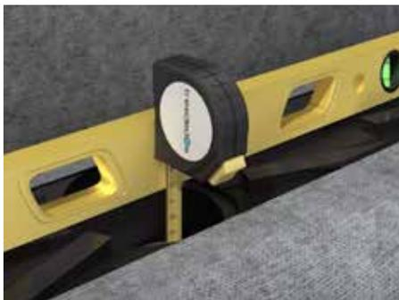
2. Medir para determinar la altura de instalación de la base del **LINEAL/SUMI LEVEL** siempre desde la base del sumidero.
