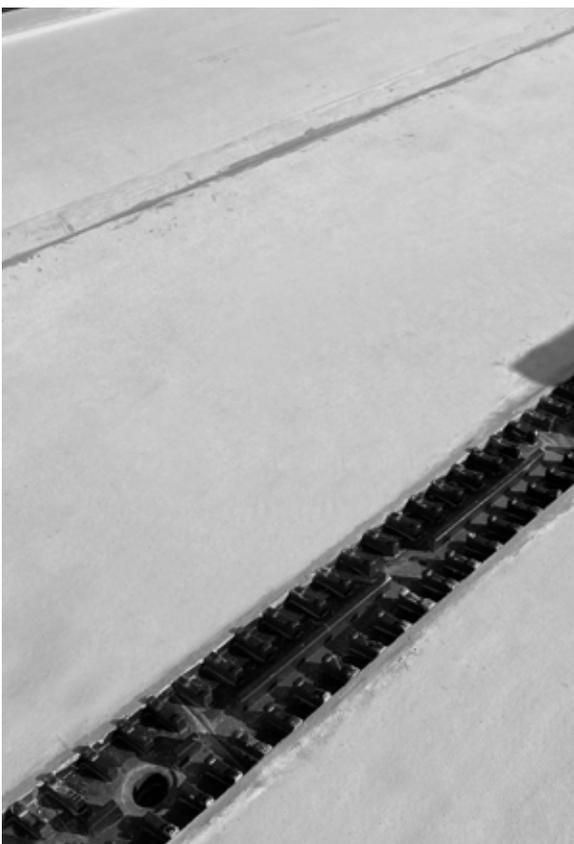
Proceder a impermeabilizar el resto del sustrato solapando siempre sobre los aleros de lámina **ECODRY50** del **WALK LEVEL** un mínimo de 10 cm. Los solapes entre láminas se deben sellar utilizando adhesivo **SEALPLUS**.
