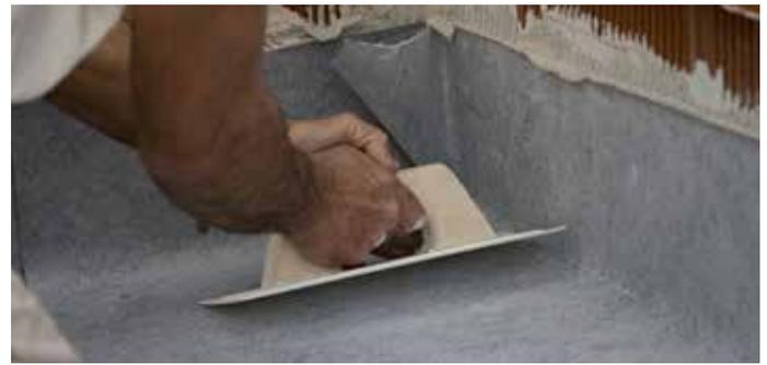
1. Comprobar la estabilidad del soporte y limpiar la superficie. A continuación aplicar cemento cola clase C2 S1/S2 con llana dentada de 6/8 mm. Aplicar el adhesivo en pequeños paños para evitar que se seque y siempre peinando en un único sentido. En ningún caso instalar la lámina sobre un cemento cola semi fraguado. **NOTA:** en rehabilitación, aplicamos el cemento cola clase C2 S1/S2 directamente sobre el pavimento antiguo.
