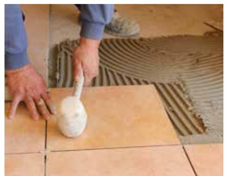
9. Colocar el pavimento directamente con cemento cola C2 S1/S2 y fijar el rodapié.
