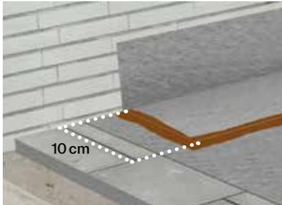
Colocar la banda perimetral **ECODRY BANDA** respetando la altura del rodapié y dejando no menos de 10 cm de solape sobre la lámina.
