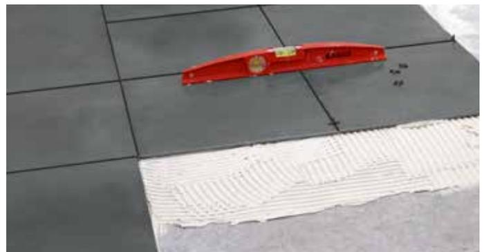
5. Con una espátula extender el adhesivo **SEALPLUS\*** para que quede bien repartido. Poner una primera capa entre láminas (1º). Rematar la junta por encima con adhesivo **SEALPLUS\*** (2º): doble sellado.
