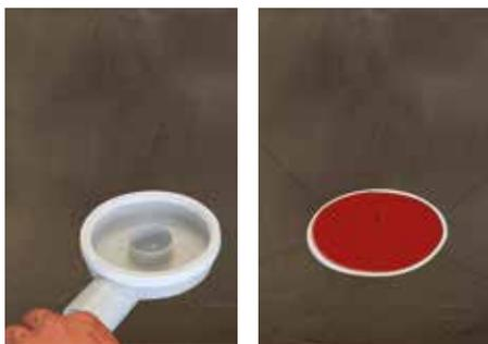
1. Conectar el sumidero a la tubería y formar las pendientes, protegiendo el interior con la tapa de color rojo que después retiraremos.
