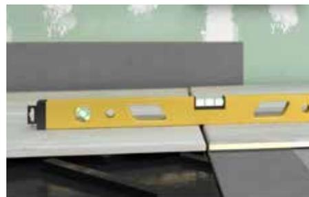
3. La cerámica del **PLATO LEVEL** debe estar al mismo nivel que la cerámica del resto del baño. Para ello, sacar los niveles con el pavimento pre-instalado siempre sobre el **PLATO LEVEL**.
