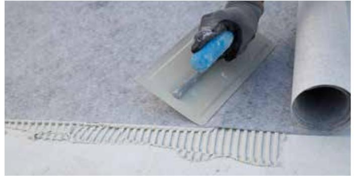
2. Presionar fuerte la lámina sobre el soporte con ayuda de la llana de plástico, asegurándose de eliminar todas las posibles bolsas de aire que se hayan generado. ATENCIÓN: una vez instalada, se deberá comprobar que la lámina esté totalmente pegada al soporte.
