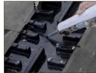
TOTAL ESTANQUEIDAD DE LAS JUNTAS MEDIANTE SELLADO CON ADHESIVO **REVESTTECHFLEX**.
