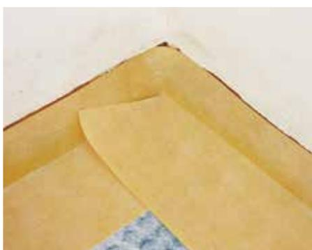
7. Realizar las uniones con los paramentos verticales con **DRY** o **ECODRY BANDA** solapando con un mínimo de 10 cm sobre la lámina **DITEC3**.
