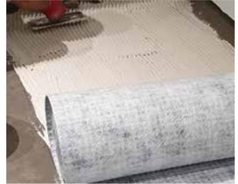
3. A continuación aplicar cemento cola clase C2 S1/S2 con llana dentada de 6/8 mm. Aplicar el adhesivo en pequeños paños para evitar que se seque y siempre peinando en un único sentido. En ningún caso instalar la lámina sobre un cemento cola semi fraguado.
