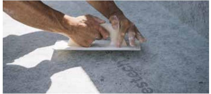
1. Comprobar la estabilidad del soporte y limpiar la superficie. A continuación aplicar cemento cola clase C2 S1/S2 con llana dentada de 6/8 mm. Aplicar el adhesivo en pequeños paños para evitar que se seque y siempre peinando en un único sentido. En ningún caso instalar la lámina sobre un cemento cola semi fraguado. **NOTA:** en rehabilitación, aplicamos el cemento cola clase C2 S1/S2 directamente sobre el pavimento antiguo.
