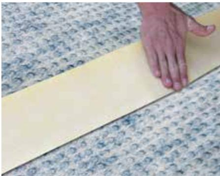
5. Realizar las uniones entre láminas con **DRY** o **ECODRY BANDA 13** y adhesivo impermeable y elástico en base cementosa.
