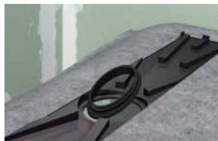
5. Sellar a la salida de la base Level presionando para repartir el adhesivo. Asegurar que la parte más gruesa de la junta queda hacia abajo. No esperar a que seque para el siguiente paso.
