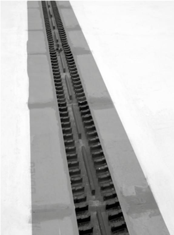
Desplegar los aleros de lámina **ECODRY50** y pegar al soporte con un adhesivo cementoso C2 S1/S2. Solapar los aleros de piezas **WALK LEVEL** contiguas usando adhesivo **SEALPLUS** de tal forma que toda la longitud del canal esté impermeabilizada en sus dos lados.
