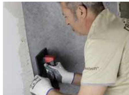
6. Presionar la lámina usando una llana de plástico para sacar el aire que se pueda haber generado.
