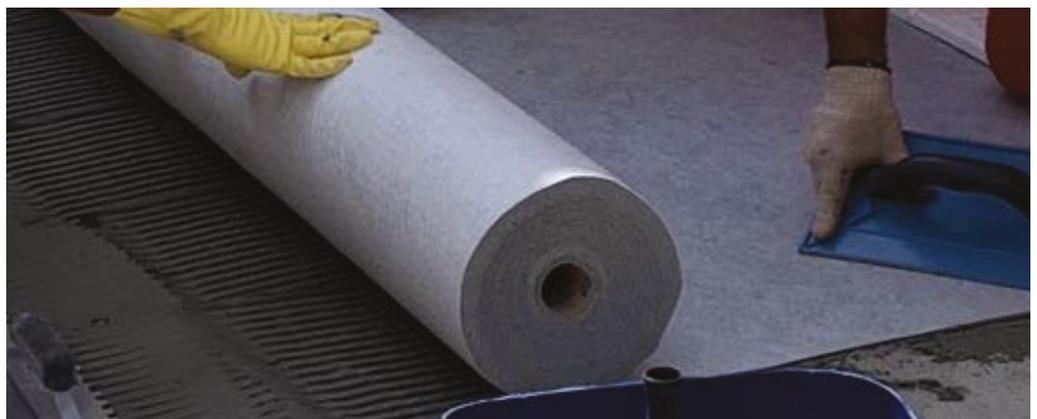
É recomendável começar a aplicação e colagem das Lâminas **ECODRY50** e **ECODRY120**, pelo piso e após na parede (utilizando a desempenadeira de 6mm), considerando que a lâmina foi cortada sem emendas entre o piso e parede com altura mínima de 20 cm acima do revestimento final. Caso seja necessário aplicar a lâmina na parede a sobreposição da lâmina **ECODRY50** ficará sobre a lâmina aplicada no piso, melhorando a segurança de impermeabilização.
