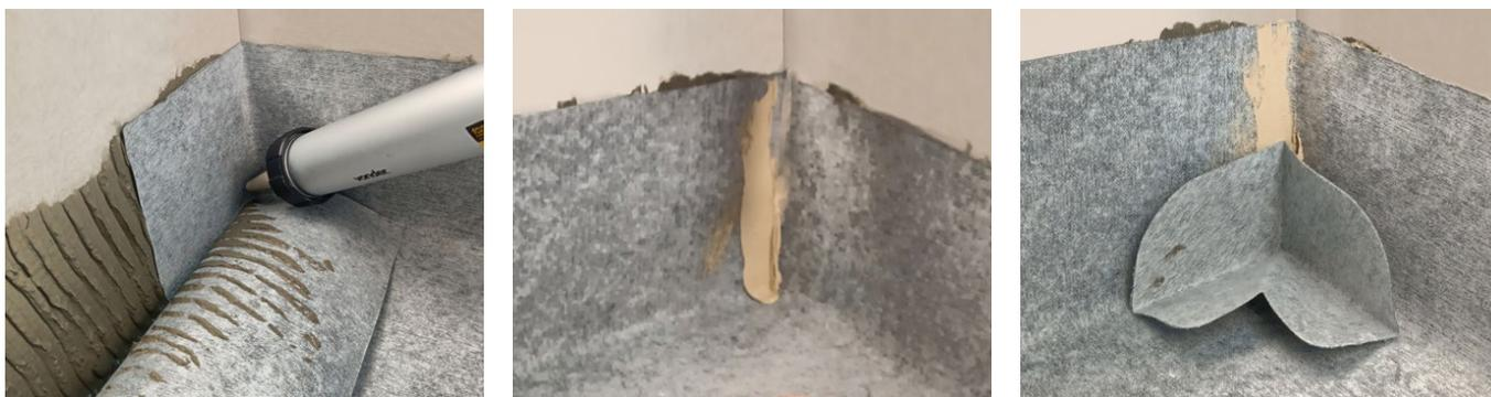
Como opcional, a lâmina pode ser dobrada sem cortes na vertical e colada na parede com argamassa AC3 e aplicado o **SEALPLUS** como reforço, sendo que nesta opção a espessura é mais elevada em função da dupla aplicação de argamassa e dobragem da Lâmina.
