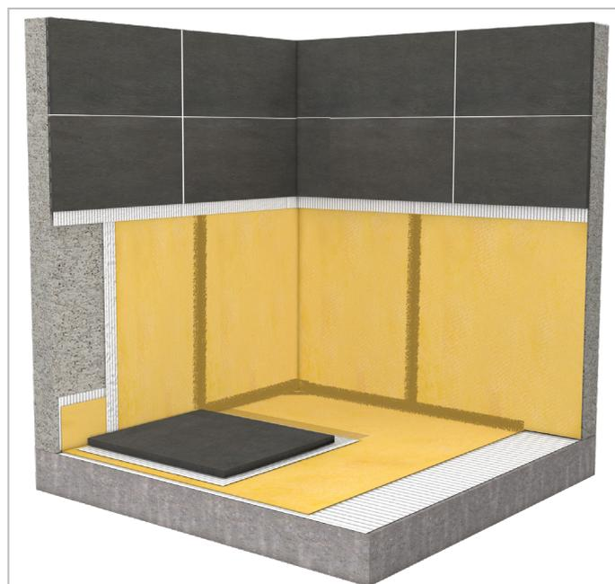
**3.** Étaler une fine couche de ciment-colle C2 S1/S2 à l'aide d'une truelle dentée de 4 mm et recouvrir le mur avec la membrane **DRY50**, en laissant un chevauchement d'au moins 5 cm entre chaque membrane. Vérifiez que celle-ci soit bien étendue et éliminez l'air qui a pu se former à l'aide de la truelle. Sceller les joints avec **SEALPLUS** par double scellement (voir point 2.)
