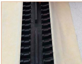
L'UNION AVEC LA MEMBRANE EST RÉSOUE, GRÂCE AUX DEUX AILERONS DE MEMBRANE ÉTANCHE DRY50 THERMOSOUDEE.
