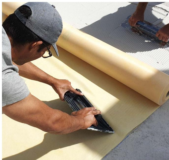
Il permet de résoudre l'imperméabilisation de tous les types de revêtement grâce à l'installation de membranes **ECODRY** ou **DRY** collées sans nécessiter d'outils ou de produits spéciaux. Sa polyvalence rend inutile l'enlèvement, dans la plupart des cas, du système d'étanchéité existant ou du revêtement de finition. Il ne nécessite pas de préparations préalables complexes du support ni d'outils ou de produits non normalement présents sur un chantier.
