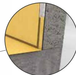
A lamina da parede cobre a lamina do chão que sobe sobre a parede. A sobreposição entre as folhas é selada com **SEALPLUS**.
