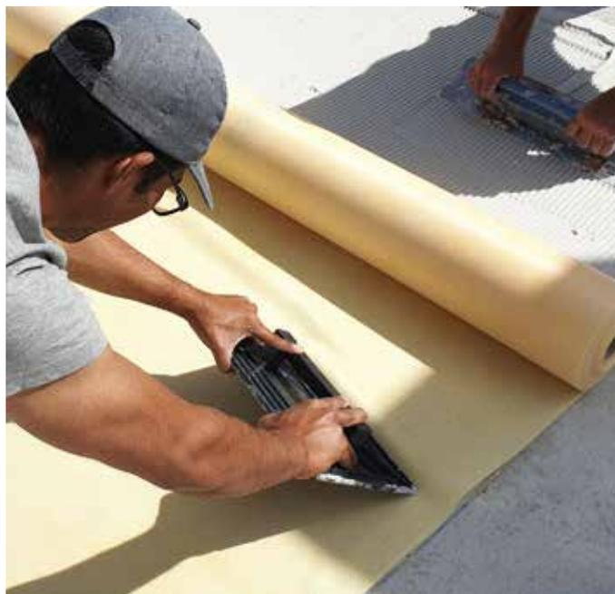
Resolve a impermeabilização de todo o tipo de coberturas através da instalação por colagem de lâminas **ECODRY** o **DRY** sem necessidade de ferramentas ou produtos especiais. A sua versatilidade faz com que não seja necessário remover, na maioria dos casos, o sistema de impermeabilização existente ou o acabamento. Não requer preparação complexa prévia do suporte, nem de ferramentas ou produtos normalmente não presentes na obra.
