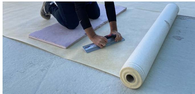
1. Comprobar la estabilidad del soporte y limpiar la superficie. A continuación aplicar cemento cola clase C2 S1/S2 con llana dentada. Aplicar el adhesivo en pequeños paños para evitar que se seque y siempre peinando en un único sentido. En ningún caso instalar la lámina sobre un cemento cola semi fraguado. **NOTA:** en rehabilitación, aplicamos el cemento cola clase C2 S1/S2 directamente sobre el pavimento antiguo.
