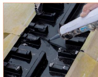
TOTAL ESTANQUEIDAD DE LAS JUNTAS MEDIANTE SELLADO CON ADHESIVO REVESTECHflex
