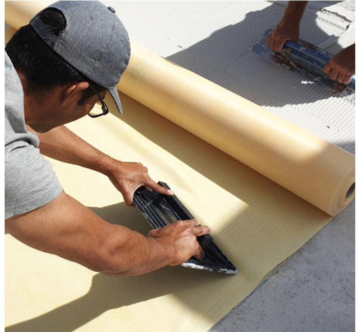
Resuelve la impermeabilización de todo tipo de cubiertas mediante la instalación adherida de láminas **ECODRY** o **DRY** sin necesidad de herramientas o productos especiales. Su versatilidad hace que no sea necesario retirar, en la mayoría de los casos, el sistema de impermeabilización existente o el pavimento de acabado. No precisa de complejas preparaciones previas del soporte, ni de herramientas o productos no presentes normalmente en obra.
