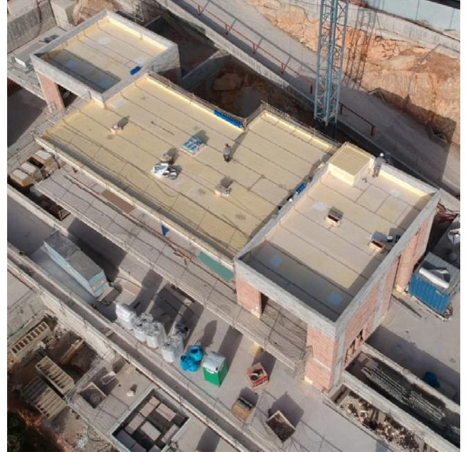
**DRY80:** lámina flexible de poliolefinas para la impermeabilización bajo protección de espacios exteriores y cubiertas planas transitables y no transitables, como terrazas, azoteas, balcones, patios, alféizares y cornisas. Constituida por una membrana de EVAC extrusionada sobre fibras de poliéster para el óptimo agarre con el cemento cola C2 S1/S2 usado en su instalación como lámina adherida. Admite unión y sellado por soldadura con aire caliente o con nuestro adhesivo **SEALPLUS**.
