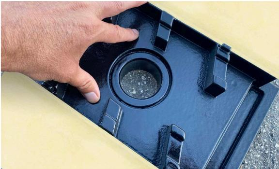
Se deben ir conectando los sumideros (salida horizontal o vertical) a la tubería de desagüe, instalando las piezas **WALK LEVEL DRAIN** o **WALK LEVEL CORNER DRAIN** con adhesivo cementoso C2 S1/S2. Comprobar que la unión entre tubos esta perfectamente sellada.
