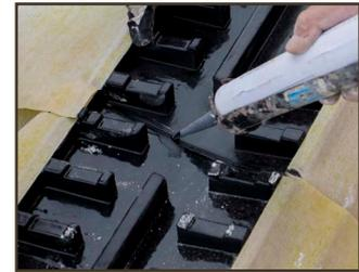
TOTAL ESTANQUEIDAD DE LAS JUNTAS MEDIANTE SELLADO CON ADHESIVO **REVESTCHFLEX**
