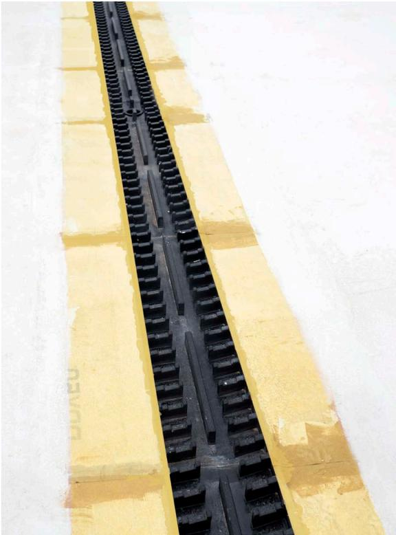
Desplegar los aleros de lámina **DRY50** y pegar al soporte con un adhesivo cementoso C2 S1/S2. Solapar los aleros de piezas **WALK LEVEL** contiguas usando adhesivo **SEALPLUS** de tal forma que toda la longitud del canal esté impermeabilizada en sus dos lados.
