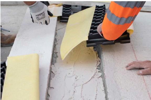
Aplicar una capa de adhesivo cementoso C2 S1/S2 sobre el soporte e ir colocando cada pieza de la composición del sistema. Rellenar todos los huecos existentes entre el canal y resto de la base del pavimento y comprobar que el canal, queda a nivel con el resto de superficie del soporte.
