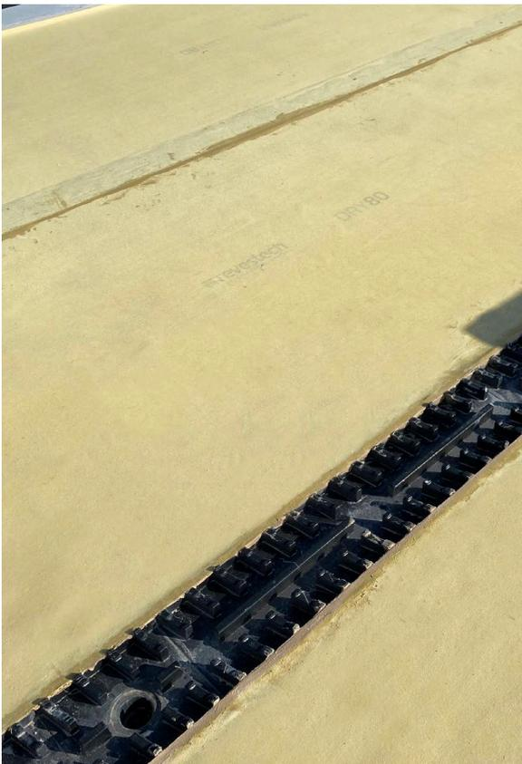
Proceder a impermeabilizar el resto del sustrato solapando siempre sobre los aleros de lámina **DRY50** del **WALK LEVEL** un mínimo de 10 cm. Los solapes entre láminas se deben sellar utilizando adhesivo **SEALPLUS**.
