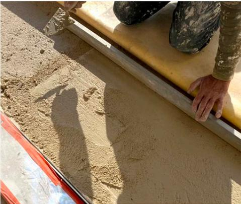
Realizar un rebaje en el soporte a lo largo de todo el canal de 6/7 cm de fondo, que nos permita nivelar la altura de las canales y de 21/22 cm o 36/37 cm para la anchura de las mismas. Comprobar que las pendientes del soporte están bien realizadas hacia el sistema **WALK LEVEL**.
