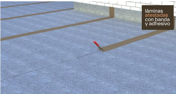
**3.** Atestar las láminas y extender el adhesivo especial **SEALPLUS**. Debido al espesor del adhesivo, usar una llana o espátula lisa que no vaya dentada, para favorecer el recubrimiento de toda la superficie de la unión.
