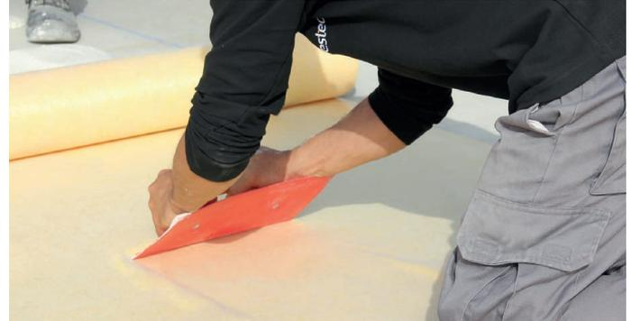
**1.** Comprobar la estabilidad del soporte y limpiar la superficie. A continuación aplicar cemento cola clase C2 S1/S2 con llana dentada. Aplicar el adhesivo en pequeños paños para evitar que se seque y siempre peinando en un único sentido. En ningún caso instalar la lámina sobre un cemento cola semi fraguado. **NOTA:** en rehabilitación, aplicamos el cemento cola clase C2 S1/S2 directamente sobre el pavimento antiguo.
