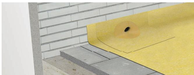
Insertar el tubo dentro de la salida horizontal del muro, haciendo un agujero en la lámina **DRY80**.
