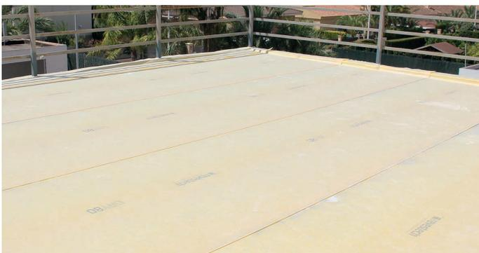
**3.** Instalar las láminas siempre a favor de la pendiente, partiendo del sumidero hacia arriba. Dejar un solape entre láminas mínimo de 10 cm.
