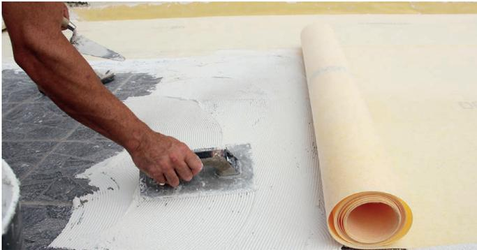
**1.** Comprobar la estabilidad del soporte y limpiar la superficie. A continuación aplicar cemento cola clase C2 S1/S2 con llana dentada. Aplicar el adhesivo en pequeños paños para evitar que se seque y siempre peinando en un único sentido. En ningún caso instalar la lámina sobre un cemento cola semi fraguado. **NOTA:** en rehabilitación, aplicamos el cemento cola clase C2 S1/S2 directamente sobre el pavimento antiguo.
