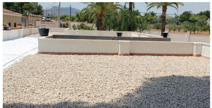
**6.** Una vez que hayamos realizado las uniones, colocaremos un geotextil de protección entre la lámina y la grava. Trabajo terminado de manera rápida, fácil y con garantía de calidad.
