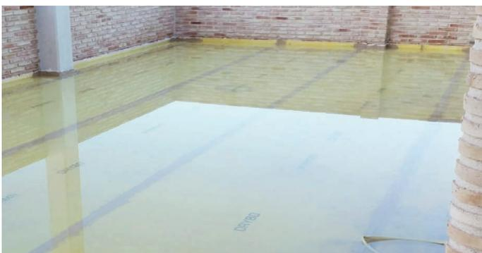
**5.** Una vez finalizada la instalación, con un tiempo de espera de 48 horas, se debe realizar una prueba de estanqueidad precisa.
