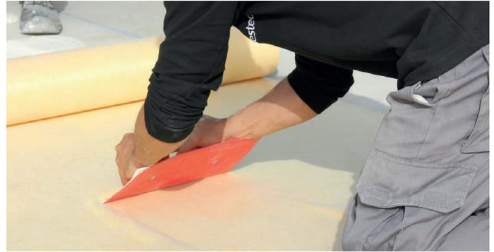
**2.** Presionar fuerte la lámina sobre el soporte con ayuda de la llana, asegurándose de eliminar todas las posibles bolsas de aire que se hayan generado. **ATENCIÓN:** una vez instalada, se deberá comprobar que la lámina esté totalmente pegada al soporte.
