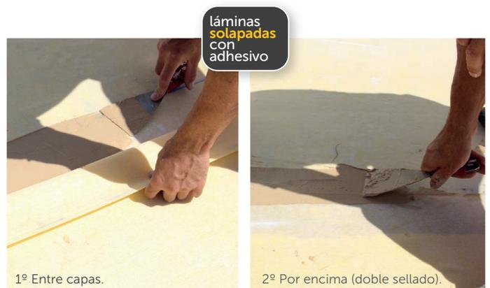
**4.** \_ Realizar las uniones con adhesivo **SEAL PLUS\***.
