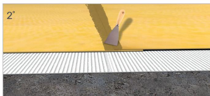
1. Limpiar bien retirando todos los residuos existentes en el soporte. Aplicar una capa fina de cemento cola C2 S1/S2 usando una llana dentada de 4 mm. Extender la lámina **DRY50** sobre el propio adhesivo, remontando un mínimo de 10 cm en la pared. Comprobar que la lámina esté bien extendida y sacar el aire que se pueda haber generado con ayuda de la llana. Formar las esquinas plegando la lámina. Para un acabado perfecto utilizar las piezas premoldeadas **DRY50 CORNERIN** y **DRY50 CORNEROUT**.
