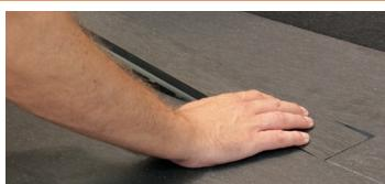
1. Colocar la cuna del lineal sobre el sumidero y adherir a la lámina con cemento cola.
