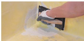
1. Conectar el sumidero a la tubería y formar las pendientes, protegiendo el interior con la tapa de color rojo que después retiraremos.
