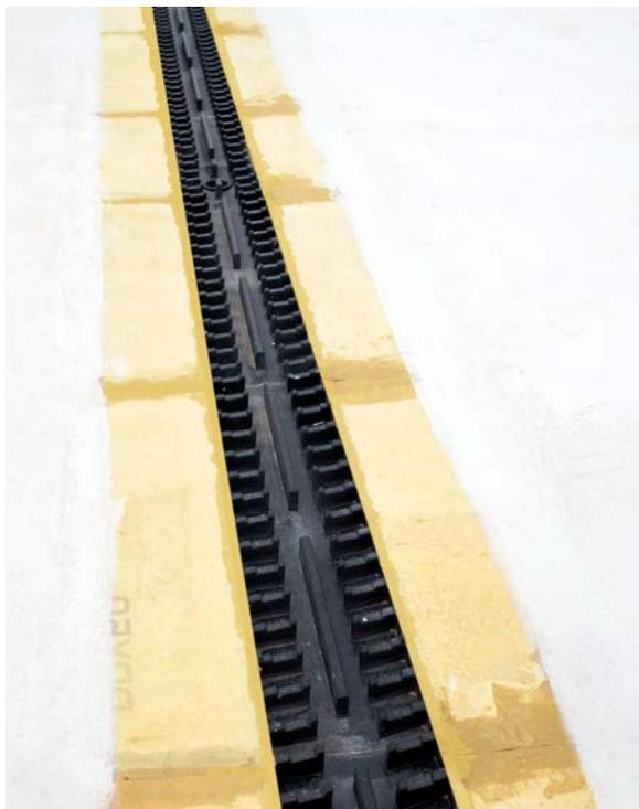
Desplegar los aleros de lámina **DRY50** y pegar al soporte con un adhesivo cementoso C2 S1/ S2. Solapar los aleros de piezas **WALK LEVEL** contiguas usando adhesivo **SEALPLUS** de tal forma que toda la longitud del canal esté impermeabilizada en sus dos lados.
