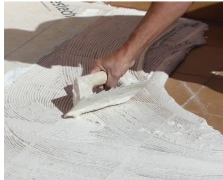
3. Aplicar cemento cola C2 S1/S2 sobre el soporte. Fijar bien la lámina al soporte, asegurándonos de eliminar con la llana todas las posibles bolsas de aire que se puedan generar.
