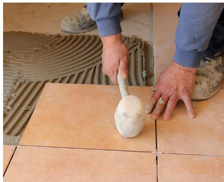
9. Colocar el pavimento directamente con cemento cola C2 S1/S2 y fijar el rodapié.
