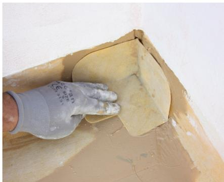
8. Utilizar los diferentes complementos **DRY80 CORNERIN**, **DRY80 CONEROUT** y **SUMI56** para resolver los puntos singulares.
