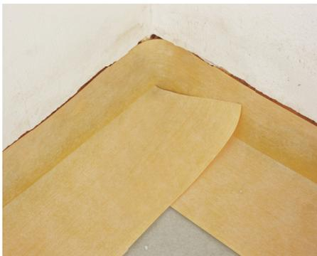
7. Realizar las uniones con los paramentos verticales con **DRY80 BANDA** solapando con un mínimo de 10 cm sobre la lámina **ACU200**.
