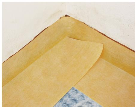
**7.** Realizar las uniones con los paramentos verticales con **DRY80 BANDA** solapando con un mínimo de 10 cm sobre la lámina **DITEC 3**.
