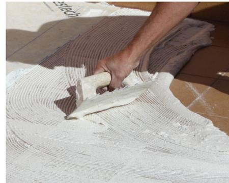
**3.** Aplicar cemento cola C2 S1/S2 sobre el soporte. Fijar bien la lámina al soporte, asegurándonos de eliminar con la lana todas las posibles bolsas de aire que se puedan generar.
