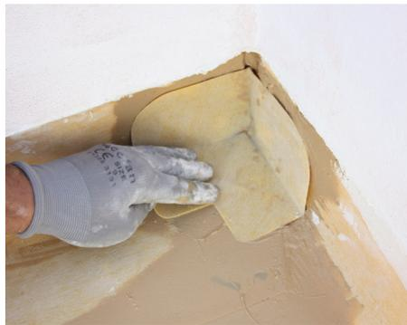
**8.** Utilizar los diferentes complementos **DRY80 CORNERIN**, **CONEROUT** y **SUMI56** para resolver los puntos singulares.
