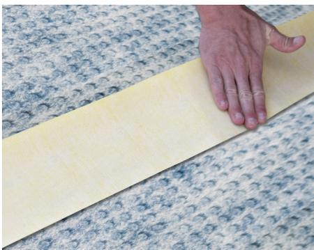
**5.** Realizar las uniones entre láminas con **DRY50 BANDA 13** y adhesivo impermeable y elástico en base cementosa.
